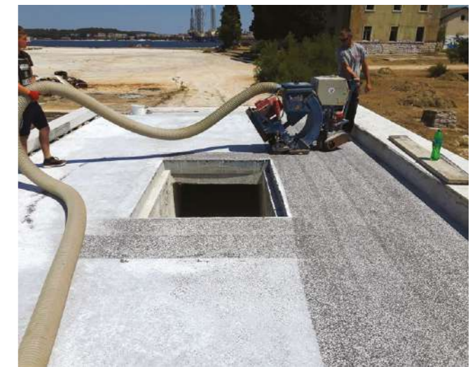
Izvedba posebnog asfalta tipa CreteoPhalt te završno sačmarenje CreteoPhalt special asphalt type execution and final shot blasting
