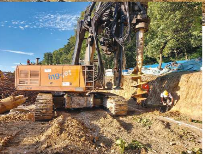
Izvedba armirano betonskih pilota Reinforced concrete piles installation
