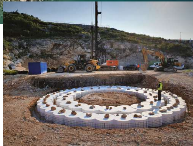
Izvedba kružnog uvodnog kanala za zasječene pilote Execution of circular inlet channel for secant piles
