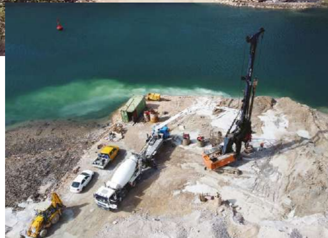
Izvedba pilota za zaštitu građevinske jame i temeljenje stupišta Pile installation for construction pit protection and piers foundation
