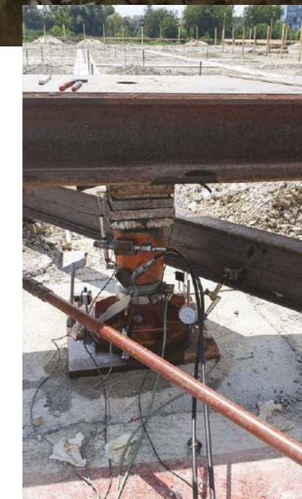
Statičko testiranje mlazno injektiranih stupnjaka Static evaluation of jet-grouting columns
