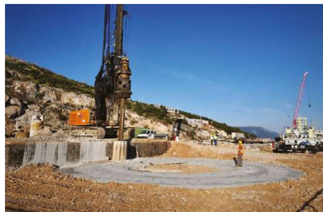
Izvedba kružnog uvodnog kanala za zasječene pilote Execution of circular inlet channel for secant piles
