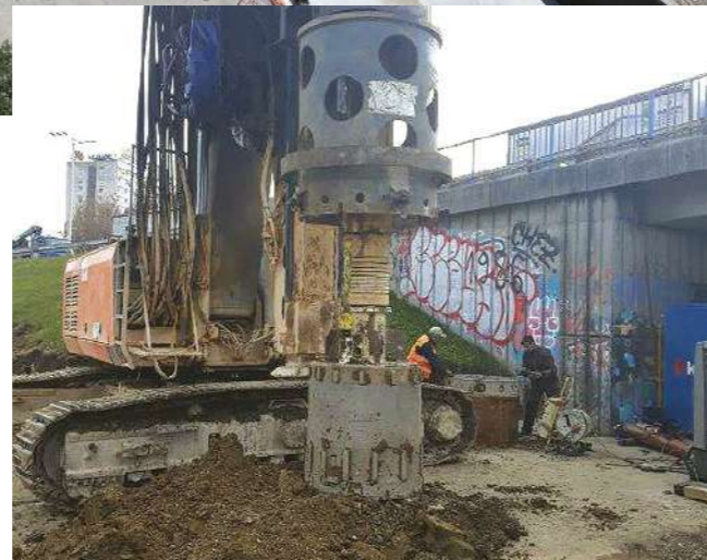
Izvedba armirano betonskih pilota za temeljenje proširenih upornjaka Construction of reinforced concrete piles for extended abutments foundations
