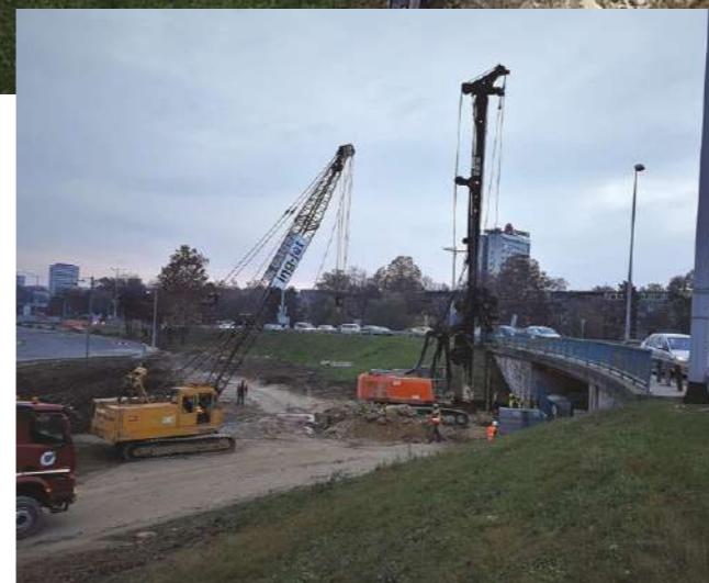
Izvedba armirano betonskih pilota za temeljenje za proširenje upornjaka Construction of reinforced concrete piles for foundations for abutment extension
