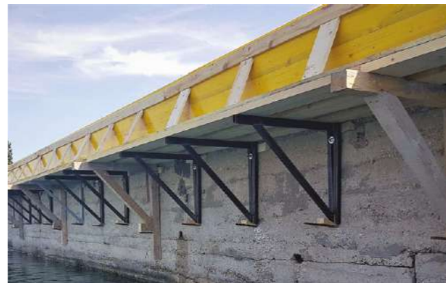
Izvedba novih greda proširenje ploče mosta New beam construction, bridge deck extension
