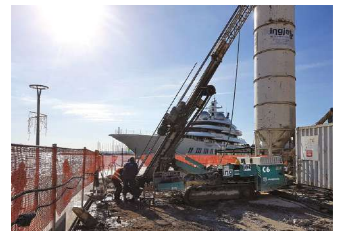
Izvedba kosih mlazno injektiranih stupnjaka na morskoj strani građevinske jame Execution of inclined jet-grouting columns on the sea side of the construction pit
