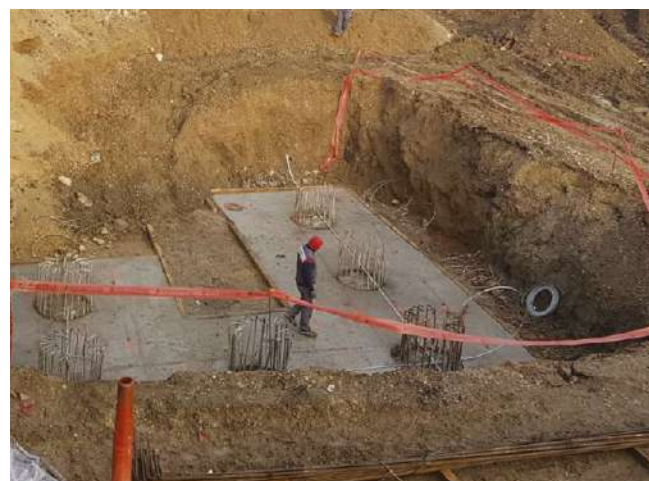
Izvedba armirano betonskih pilota za temeljenje proširenih upornjaka Construction of reinforced concrete piles for extended abutments foundations
