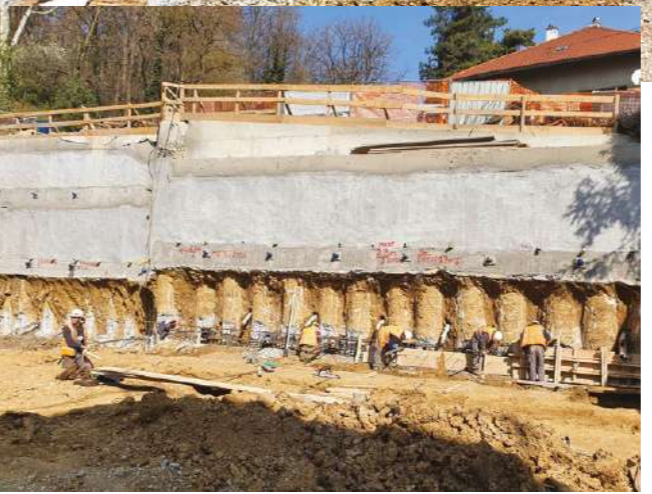
Izvedba sidara i mlaznog betona Anchor and shotcrete installation
