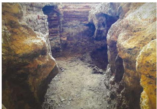
Gore: Ojačanje temelja i zaštita građevinske jame Dolje: Ojačanje temelja i produbljenje podruma
