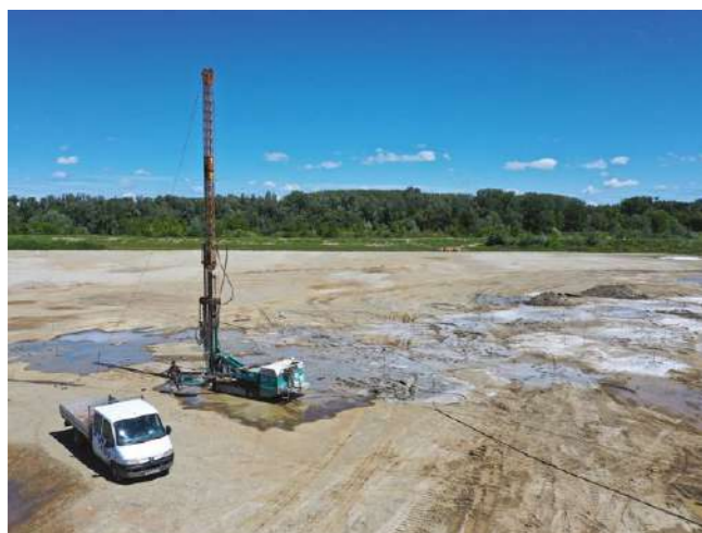
Izvedba monofluidnih mlazno injektiranih stupnjaka Monofluid jet-grouting column execution
