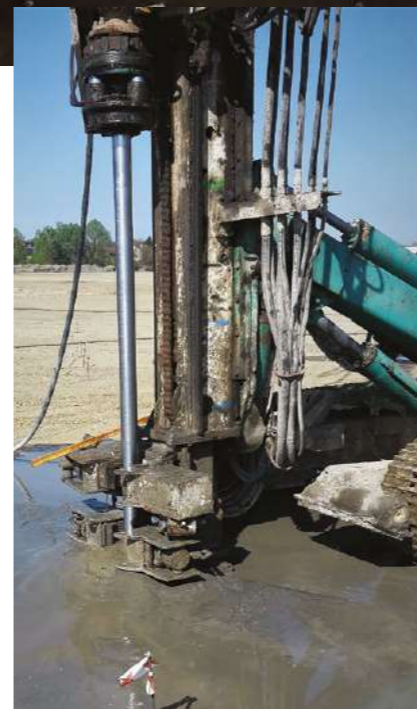
Injektiranje pod tlakom od 400 bar-a Grouting at 400 bar pressure
