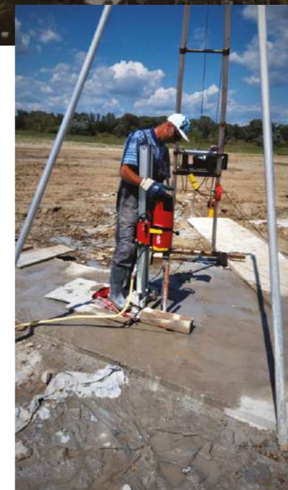
Kontrola kvalitete - jezgrovanje stupnjaka Quality control - Columns core drilling
