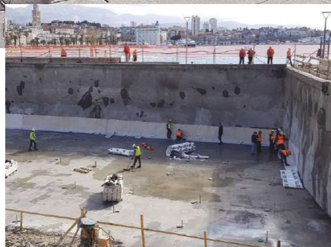
Vlačni mikropiloti za rješavanje problema uzgona, izvedba podložnog betona i postavljanje hidroizolacije Tensile micropiles to solve buoyancy, base concrete installation and waterproofing
