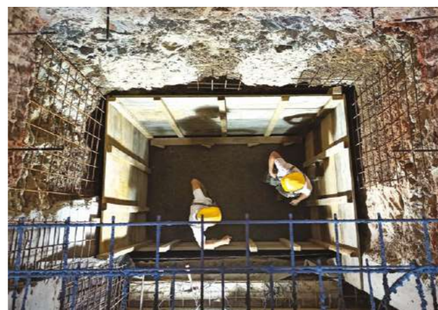
Gore: Specijalna bušilica za rad u skučenom prostoru Dolje: Ojačanje temelja i produbljenje podruma
