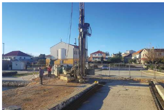
Donji most - oštećeni most; izvedba radnog platoa; izvedba mlazno injektiranih stupnjaka Lower bridge - damaged bridge; working plateau performance; jet-grouting columns execution
