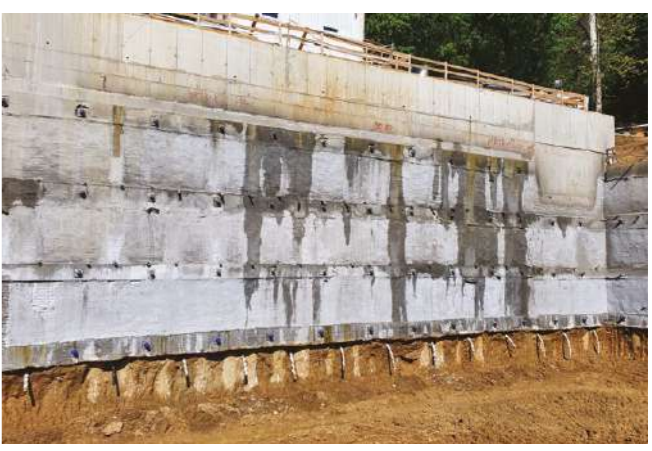
Izvedba sidara i mlaznog betona Anchor and shotcrete installation
