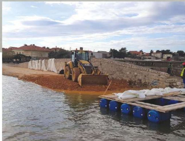
Donji most - oštećeni most; izvedba radnog platoa; izvedba mlazno injektiranih stupnjaka Lower bridge - damaged bridge; working plateau performance; jet-grouting columns execution
