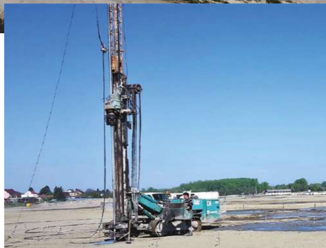
Izvedba monofluidnih mlazno injektiranih stupnjaka Monofluid jet-grouting column execution
