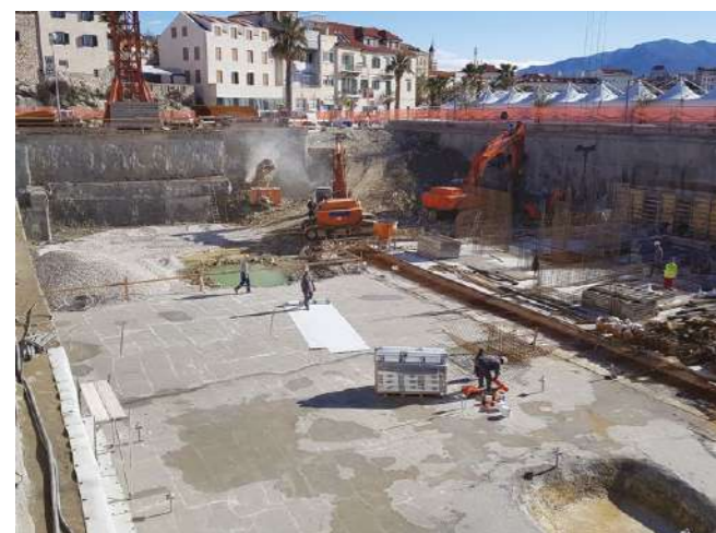
Vlačni mikropiloti za rješavanje problema uzgona, izvedba podložnog betona i postavljanje hidroizolacije Tensile micropiles to solve buoyancy, base concrete installation and waterproofing
