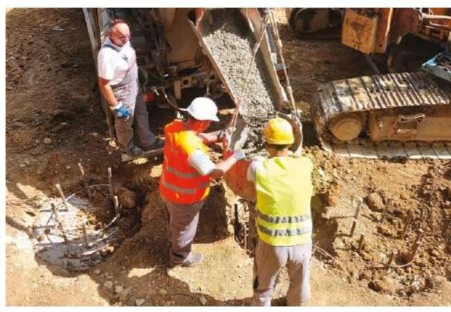
Izvedba armirano betonskih pilota Reinforced concrete piles installation
